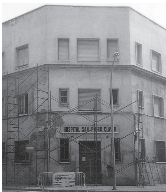
Façana de l'Hospital abans de l'enderroc (FAPSPC).
