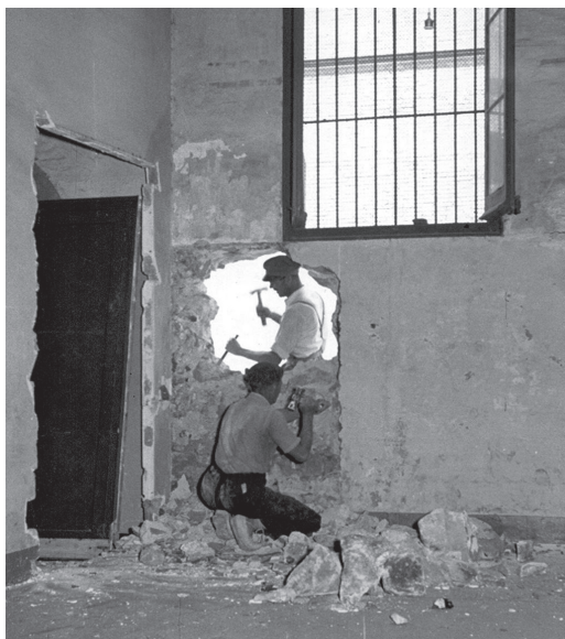
Obres del dispensari (1950) (FAPSPC).
