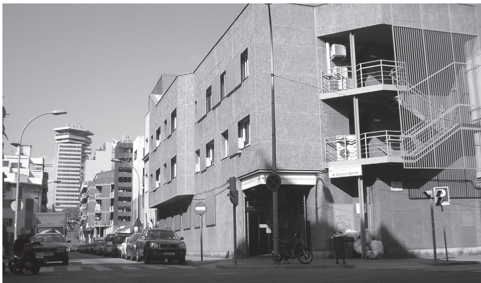
L'hospital a la dècada dels 80, amb planta baixa i dos pisos
