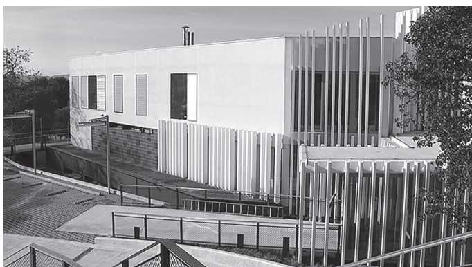
Vista exterior de la Residència Tres Pins a la muntanya de Montjuïc.
